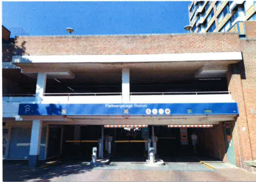
Figuur 4.3: In- en uitritten parkeergarage Station
